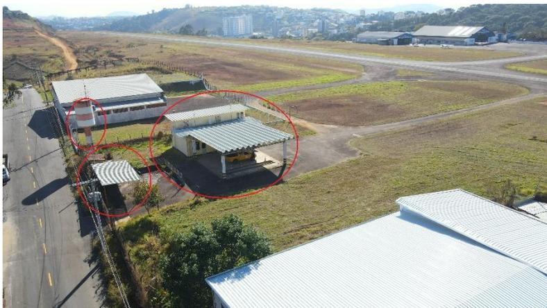
**4.7 SICOR ED-28338:** Demolição manual de construção em alvenarias de vedação, com espessura máxima de 15cm, inclusive remoção com reaproveitamento de esquadrias, afastamento e empilhamento, exclusive transporte e retirada do material demolido/removido não reaproveitável.
